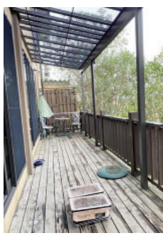
設置した屋根
